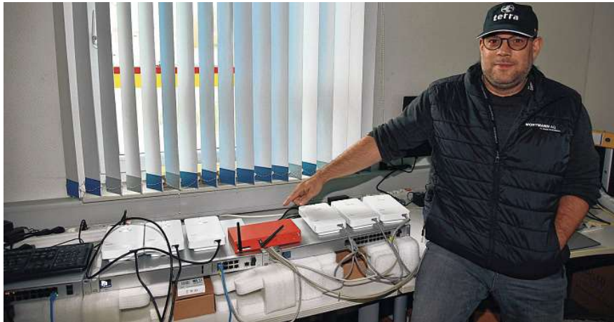
Marco Hildebrand-Lembke: Mit den Basiskomponenten einer modernen Cloud Telefonanlage, bei der Datensicherheit an erster Stelle steht, wie der kleine rote Kasten – eine Firewall – beweist. Fotos (2): Dirk Hansemann
